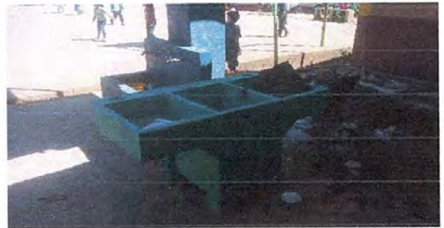
Foto 6: Sustitución de Pila
