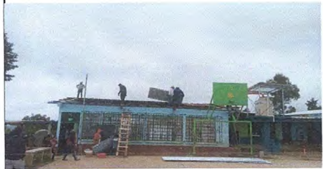
Foto 4: Sustitución de Techo Aluzinc
