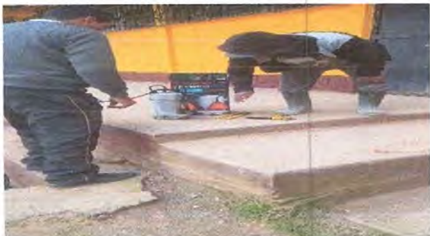
Foto1: Sustitución de Bomba de agua
